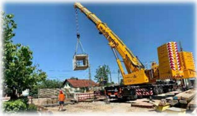
Am Wochenende vom Freitag den 13.05.2022 bis Montag den 16.05.2022 wurden am Bahnhof Sünching zwei Gleisjoche abgebaut und eine Baugrube mit einer Tiefe von ca. fünf Metern ausgehoben. Mit einem gigantischen Kran wurden dann die Rahmenteile für die neue Bahnsteigunterführung eingehoben.
